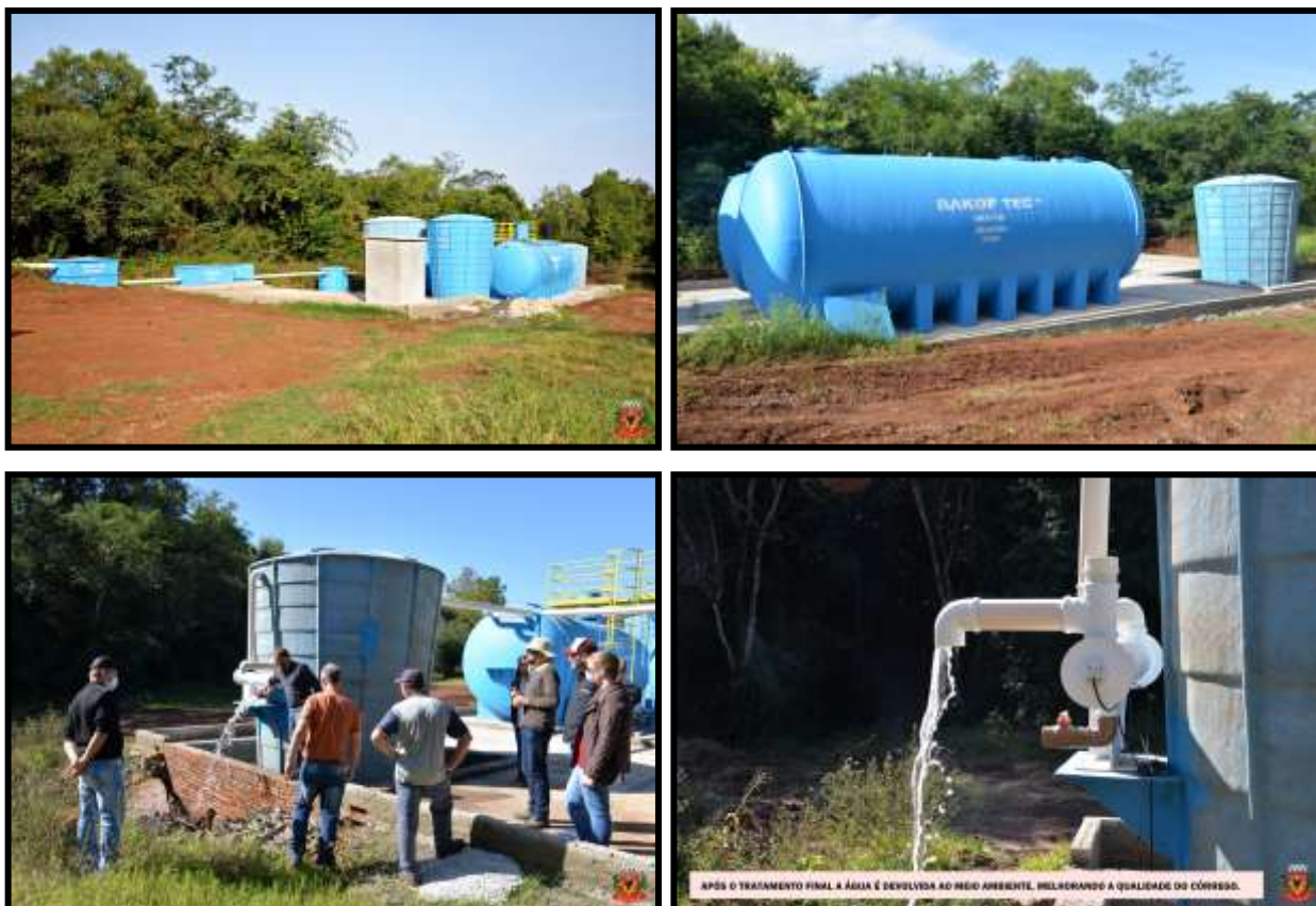
Figura 7: Registro fotográfico da ETE – Estação de Tratamento de esgoto implantada no município de Nova Candelária/RS.
